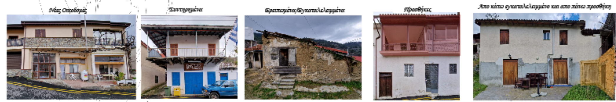
■ Συντηρημένα ■ Προσθήκες ■ Νέες Οικοδομές ■ Ερειπωμένα/Εγκαταλελειμμένα ■ Απο κάτω εγκαταλελειμμένο και απο πάνω προσθήκη
